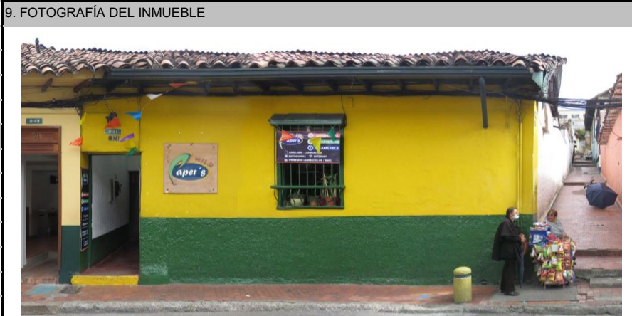
Fuente: Equipo Fotografía PEMP Patrimonio Inmueble
